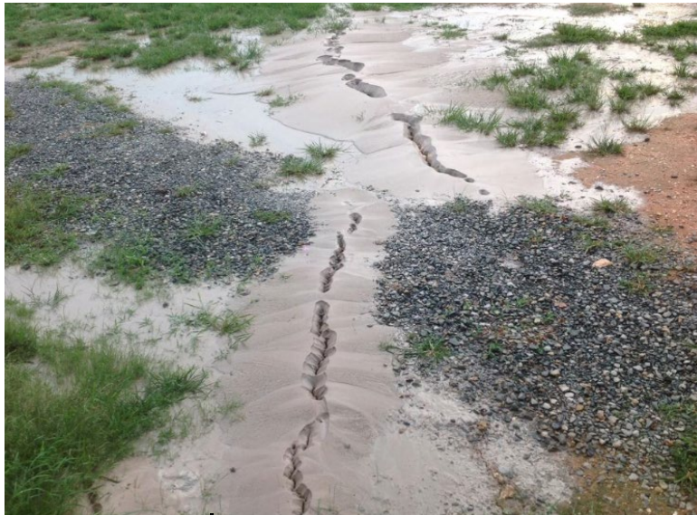
Liquefaction ที่ บ้านเหมืองหลวง อำเภอพาน จ. เชียงราย ขนาดแผ่นดินไหว 6.8 วันที่ 5/5/2014
