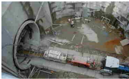
งานอุโมงค์และดันท่อใต้ดิน
