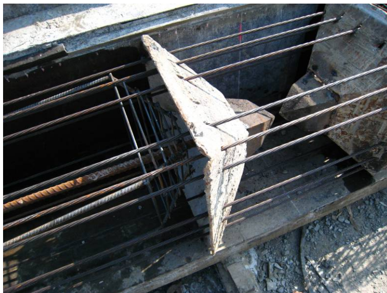
ภาพที่ 7 Steel Shoe เพื่อป้องกันปลายเสาเข็มและตอกกระแทกหินลอย
