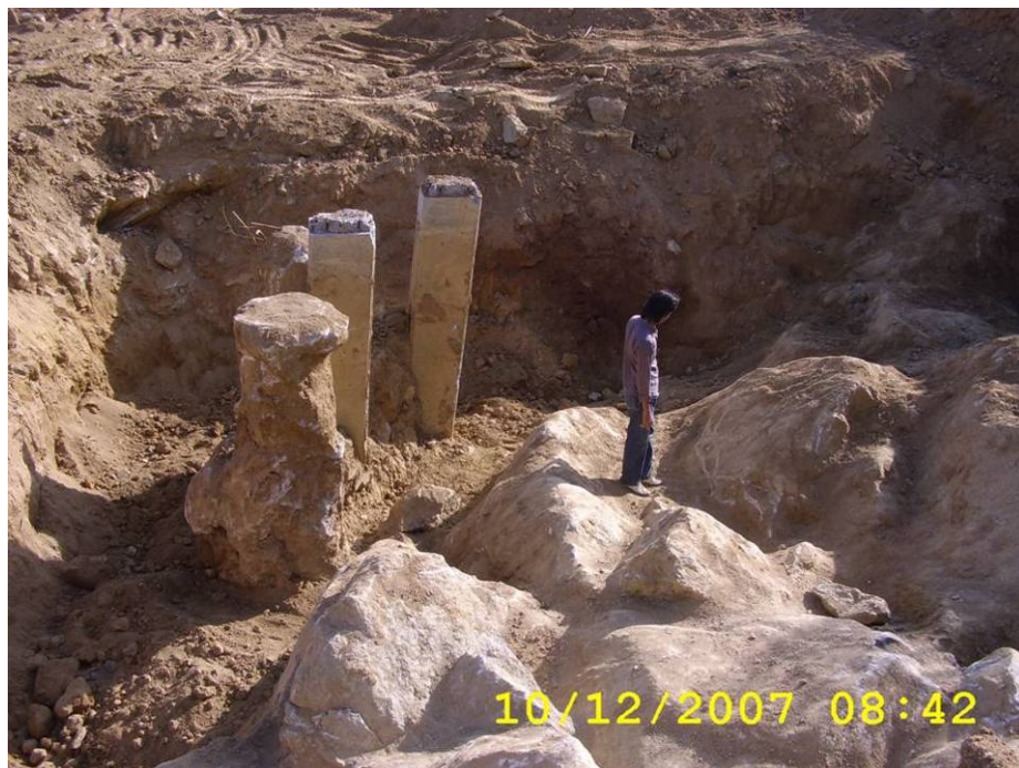
ภาพที่ 19 ลักษณะความไม่เรียบของหน้าหินที่มีการเอียงตัวตามชุดรอยแตกของหิน จากรูปจะเห็นเสาเข็มตอกใหม่และเสาเข็มเจาะระบบแห้งเดิม
