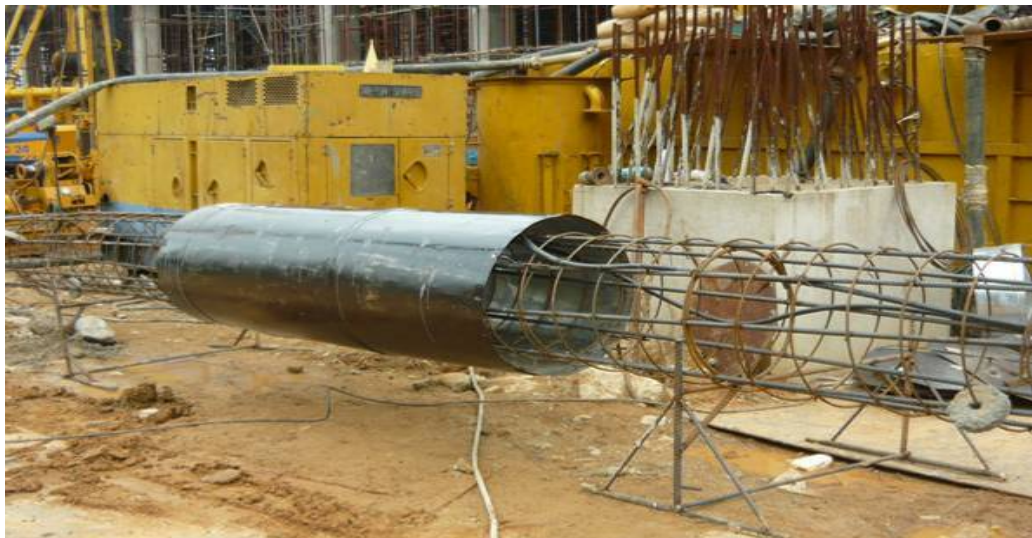
ภาพที่ 25 แผ่นสังกะสีเพื่อลดแรงฝึกระหว่างเสาเข็มเจาะกับฐานรองคอนกรีตเดิม
