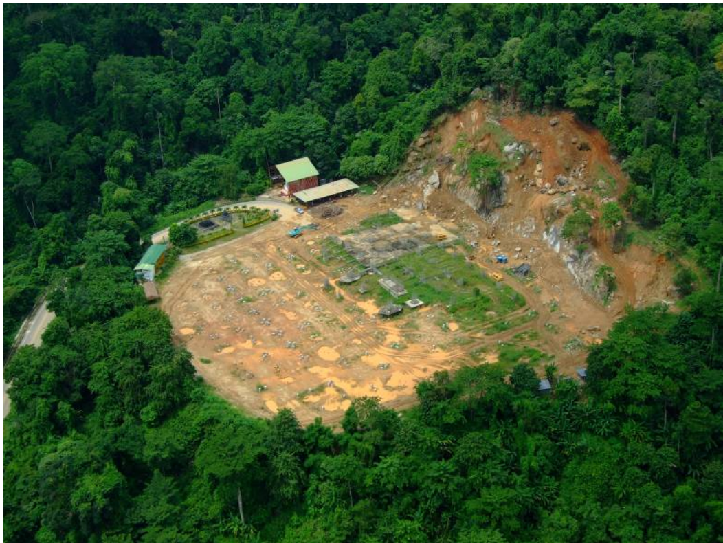
ภาพที่ 3 พื้นที่ดำเนินงานก่อสร้าง
