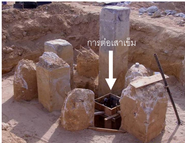
ภาพที่ 22 การทำแบบหล่อเพื่อตอเสาค้ำที่จม
