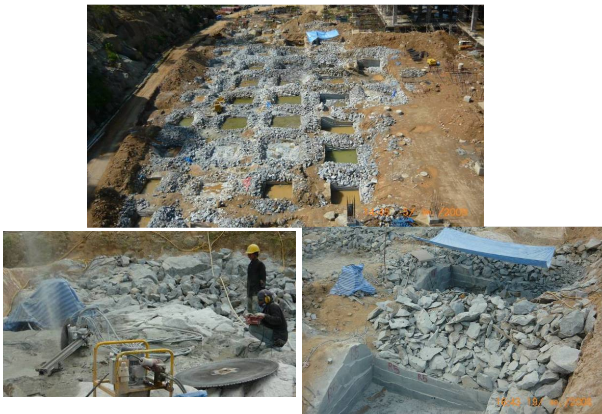
ภาพที่ 33 การตัดหินเพื่อทำฐานรากแผ่
