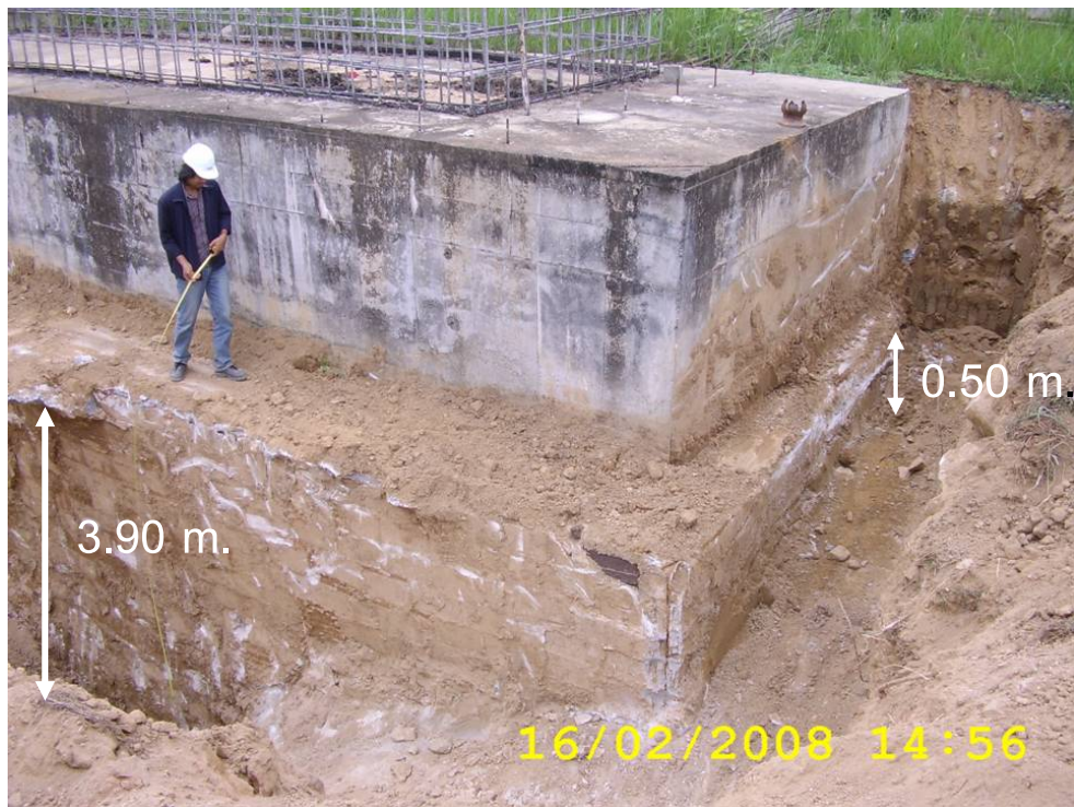
ภาพที่ 23 ฐานคอนกรีตปรับระดับที่ไม่เสริมเหล็กและมีความหนาต่างกัน
