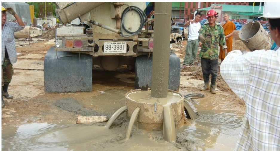
ภาพที่ 26 การก่อสร้างเสาเข็มเจาะในหิน
