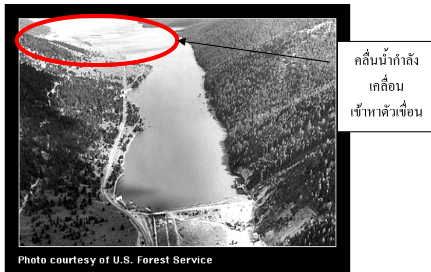
รูปที่ 4 คลื่นในอ่างเก็บน้ำเนื่องมาจากแผ่นดินไหว (Seiches) เขื่อน Hebgen ประเทศสหรัฐอเมริกา
