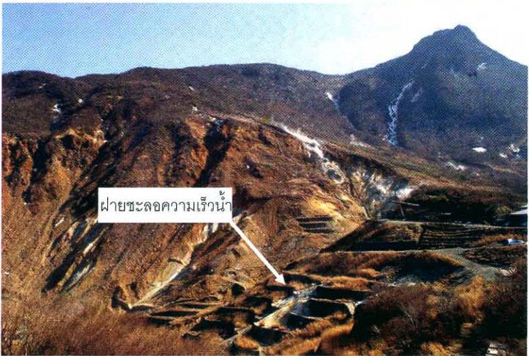
รูปที่ 15 การบรรเทาความเสียหายจากโคลนถล่ม
