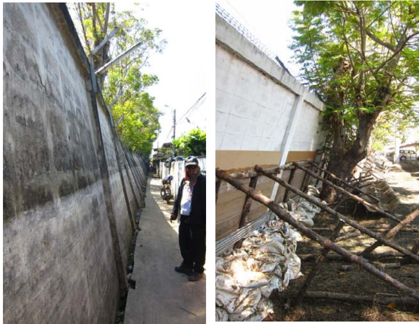
รูปที่ 6 ตัวอย่างการล้าของกำแพงเนื่องจากแรงดันน้ำ
