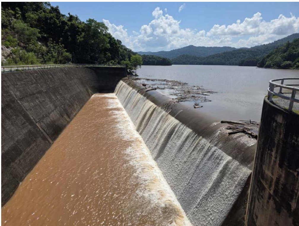
รูปที่ ๔ อาคารระบายน้ำล้นของเขื่อนคลองตรอน
