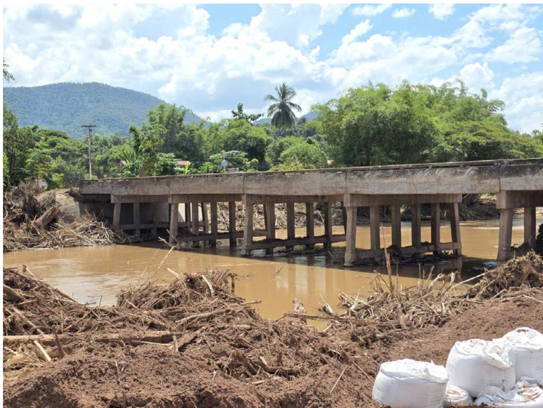
รูปที่ ๑๐ สะพานแบบดัดที่ต่อม่อสามารถกีดขวางการไหลของน้ำได้ง่ายเมื่อมีเศษซากการไหลมาขวาง
