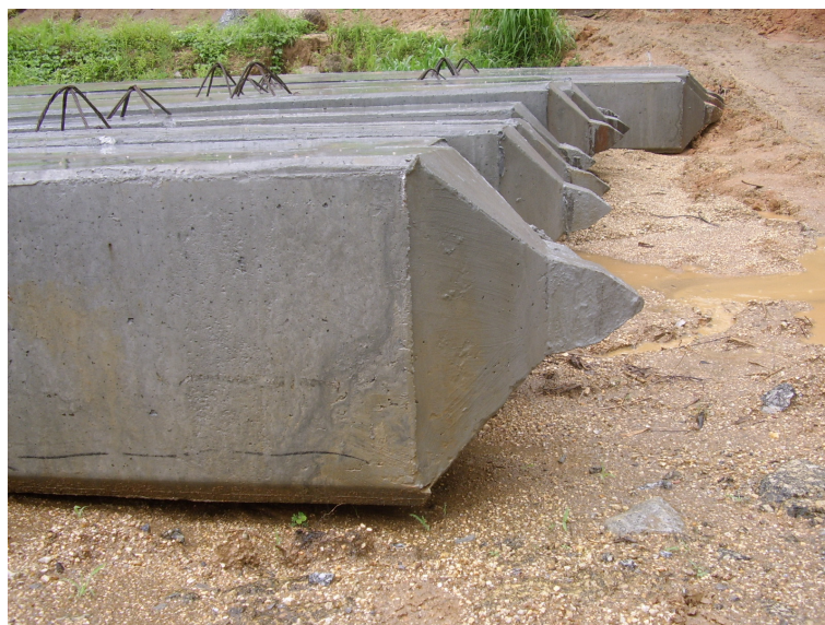
รูปที่ 4 Steel Shoe เพื่อป้องกันปลายเสาเข็มและตอกกระแทกหินลอย
