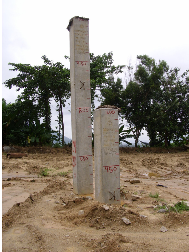
รูปที่ 7 ปลายเสาเข็มต่างระดับกันแม้จะอยู่ห่างกันไม่มาก
