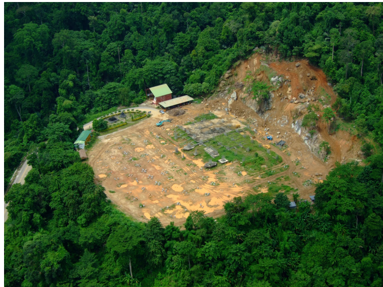
รูปที่ 2 พื้นที่ดำเนินงานก่อสร้าง
