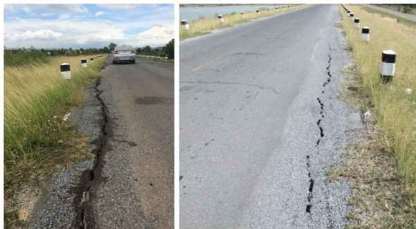
รูปที่ 3 รอยแตกตามยาวที่พบบนสันเขื่อนทั้งด้านเหนือน้ำและท้ายน้ำ [2]
