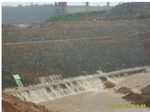
รูปที่ 4 น้ำที่ล้นข้าม Cofferdam ระหว่างก่อสร้างและไหลผ่านเขื่อนแควน้อย (พ.ศ.2550)
