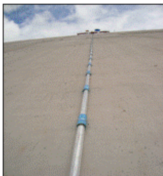
ภาพที่ 28 ลักษณะเครื่องมือ Inclinometer ติดตั้งตามลาดเขื่อน
