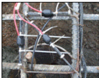
ภาพที่ 41 ลักษณะเครื่องมือ Strain Meter และการติดตั้ง
