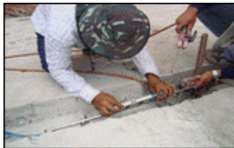
ภาพที่ 31 ลักษณะเครื่องมือ Joint Meter ติดตั้งระหว่างแผ่นคอนกรีต
