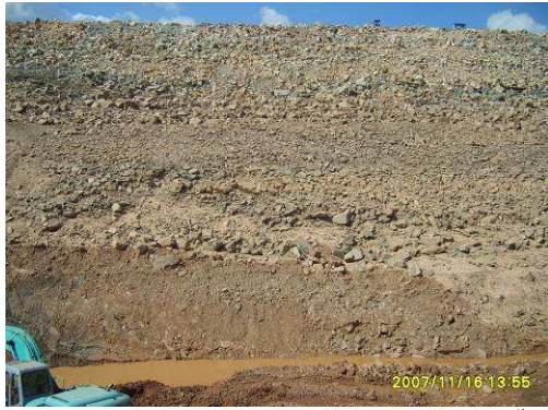
ภาพที่ 37 การไหลของหิน Zone 3A บริเวณด้านเหนือน้ำ
