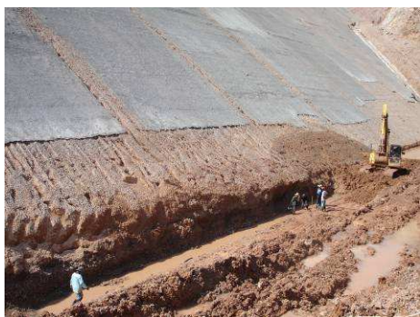
ภาพที่ 39 ความเสียหายจากการกัดเซาะของน้ำผิวดินและน้ำฝนของวัสดุ โชน 2C
