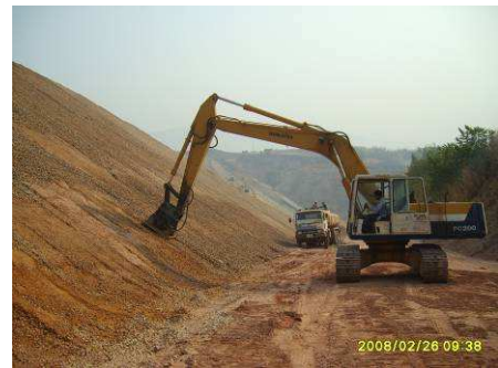
ภาพที่ 16 การบดอัดวัสดุโซน 2C ในแนวลาดเอียงโดยใช้ Vibrating Plate ติดกับรถ Backhoe
