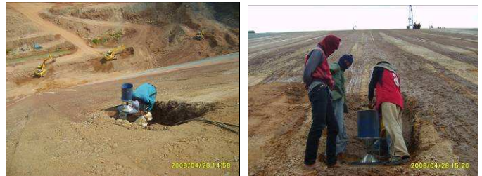
ภาพที่ 20 การทดสอบความแน่น (Density Test) โดยวิธี Sand Cone สำหรับวัสดุ 2C
