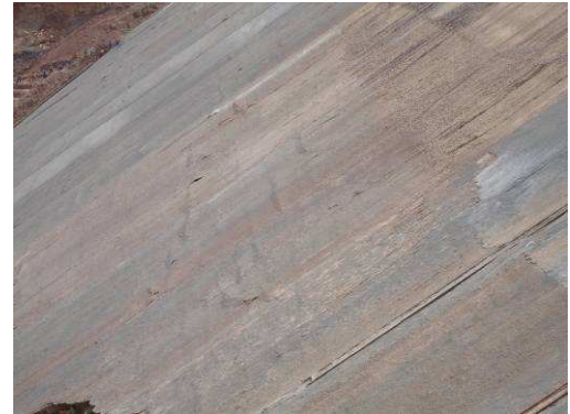
ภาพที่ 40 คอนกรีตฉีคพื้น(Shotcrete) เกิดการเลื่อนไหล
