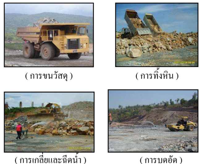
ภาพที่ 12 ขั้นตอนถมบดอัดหินการก่อสร้างเขื่อนแควน้อย
