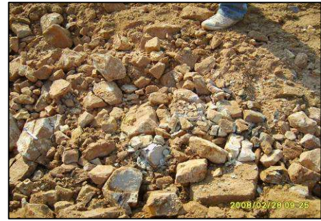
ภาพที่ 35 การแตกของวัสดุหินถมหลังการบดอัด
