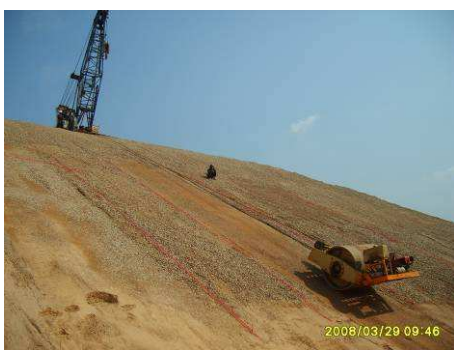
ภาพที่ 14 การบดอัดวัสดุโซน 2C ในแนวลาดเอียงโดยใช้ Vibrating Roller
