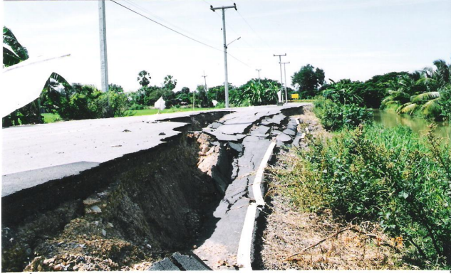
รูปที่ 1 ตัวอย่างความเสียหายของถนนริมคลอง
