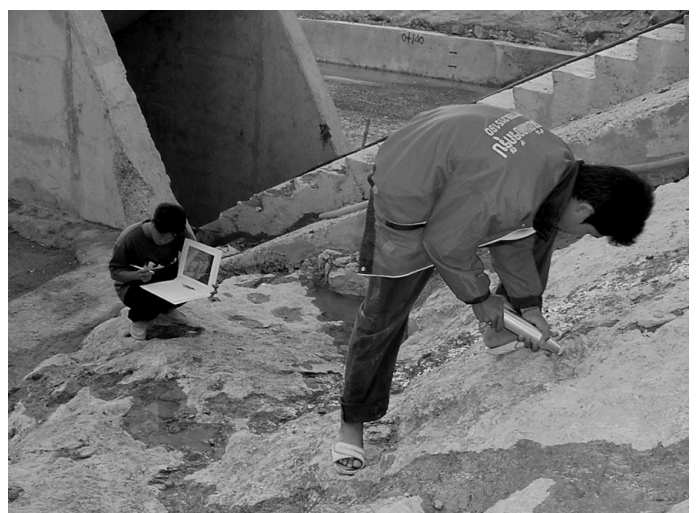
รูปที่ 6 การเตรียมพื้นผิวฐานรากและการทดสอบ Schmidt Hammer Test
