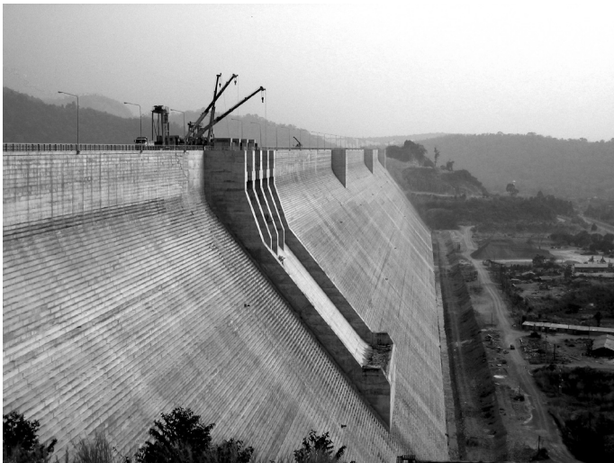
รูปที่ 1 สภาพเขื่อนคลองท่าด่านฯ ระหว่างการก่อสร้างบริเวณ เขื่อน RCC B
