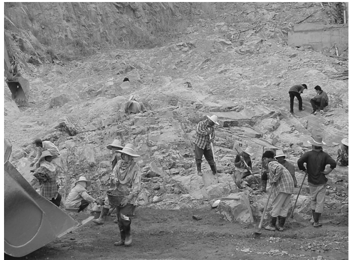
รูปที่ 4 การเก็บทำความสะอาดขุดรอก และทำความสะอาดฐานรากบริเวณฐานชั้น
