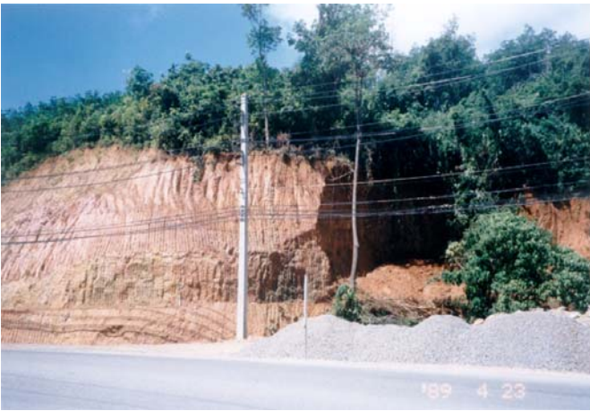
รูปที่ 2 ลาดดินธรรมชาติหรือที่กัดเซาะเป็นแนวคิง
