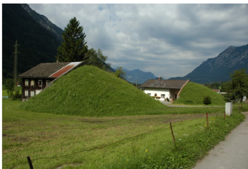
รูปที่ 19 โครงสร้างเปี่ยงทิศทางการไหลดินโคลนถล่ม
