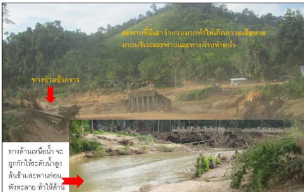
รูปผนวกที่ 3 สะพานข้ามลำน้ำซึ่งมีเสาสะพานจำนวนมาก กลายเป็นเขื่อนขนาดย่อมกีดขวางการไหลของเศษซากไม้และตะกอนดิน เมื่อไม่สามารถถ่วงน้ำหนักไหวจึงพังทลาย
