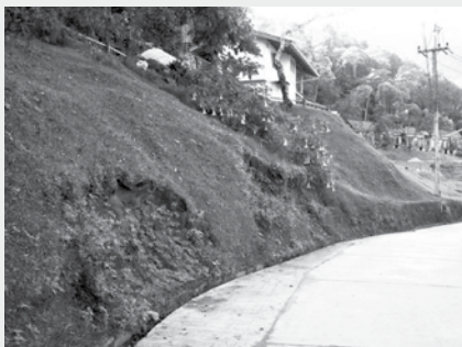
รูปที่ 7 การปลูกพืชเพื่อซ่อมแซมหน้าดินที่ถูกกัดเซาะในพื้นที่ชัน
