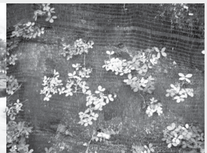
รูปที่ 7 การปลูกพืชเพื่อซ่อมแซมหน้าดินที่ถูกกัดเซาะในพื้นที่ชัน
