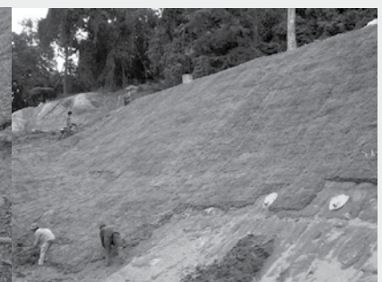
รูปที่ 8 การใช้ดินเหนียวปิดทับดินโปร่งน้ำและปลูกหญ้า
