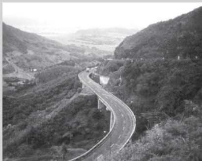
รูปที่ 5 การสร้างทางยกระดับแทนการตัดลาดเขา
