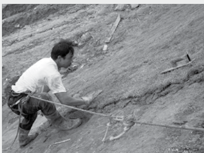
รูปที่ 8 การใช้ดินเหนียวปิดทับดินโปร่งน้ำและปลูกหญ้า
