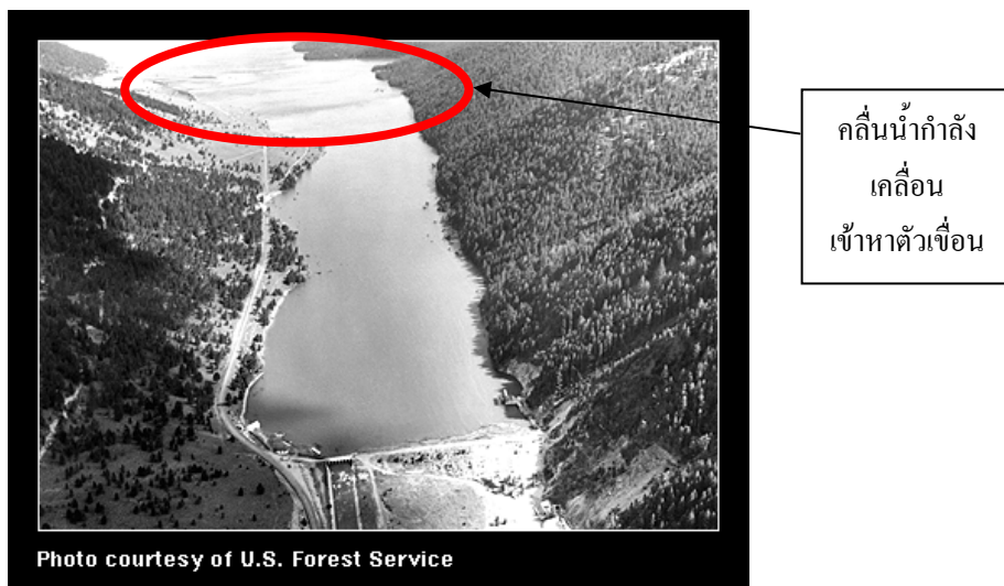
รูปที่ 25 คลื่นในอ่างเก็บน้ำเนื่องจากแผ่นดินไหว (Seiches) เขื่อน Hebgen ประเทศสหรัฐอเมริกา
