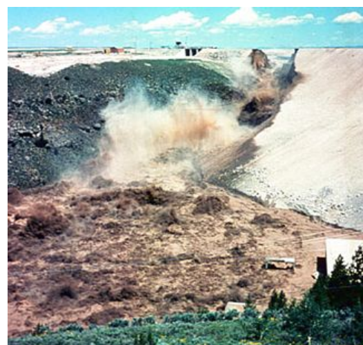
รูปที่ 29 ลักษณะการพิบัติของเขื่อน Teton Dam
