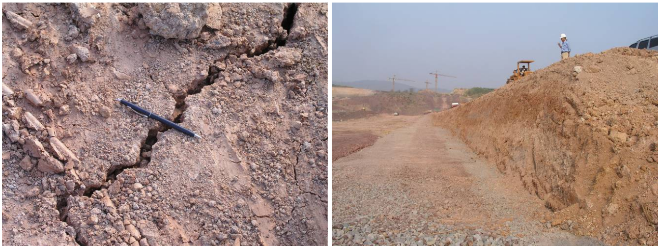
รูปที่ 11 การแตกของดินแกนเขื่อนเนื่องจากการทิ้งค้างให้เกิดการระเหยของน้ำ
