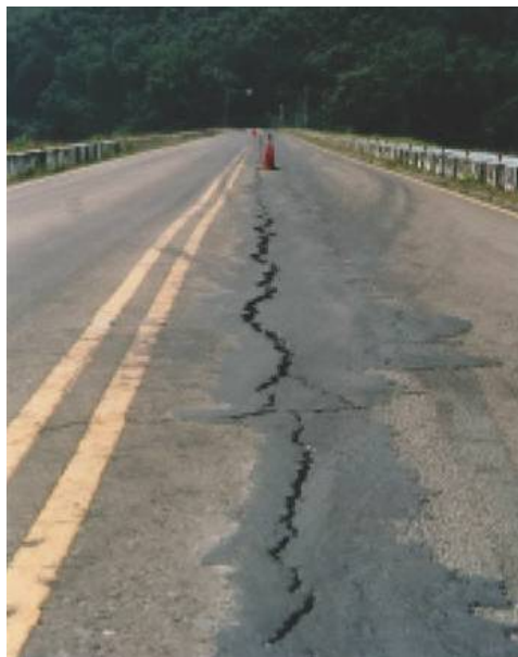
รูปที่ 12 รอยแตกขนานแนวสันเขื่อน
