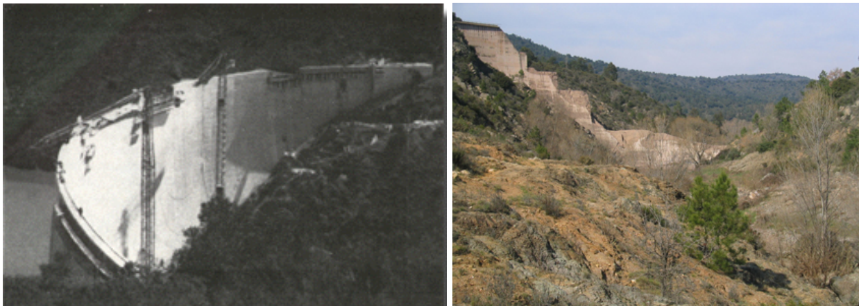
รูปที่ 33 เขื่อน Malpasset ก่อนและหลังการพิบัติ
