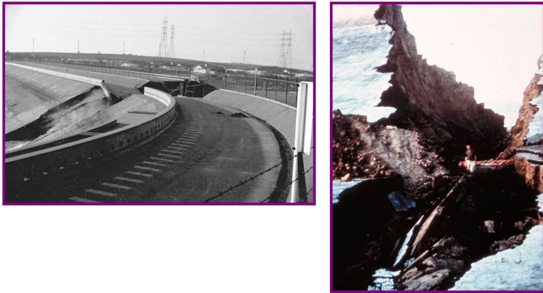
รูปที่ 15 การพิบัติเนื่องจากการแตกภายในตัวเขื่อน
