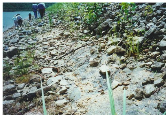
รูปที่ 22 การพิบัติจากการกัดเซาะ
