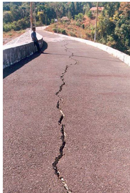
รูปที่ 12 รอยแตกขนานแนวสันเขื่อน
