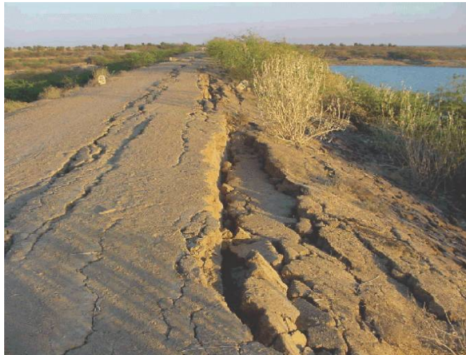
รูปที่ 26 รอยแตกขนานแนวสันเขื่อน
