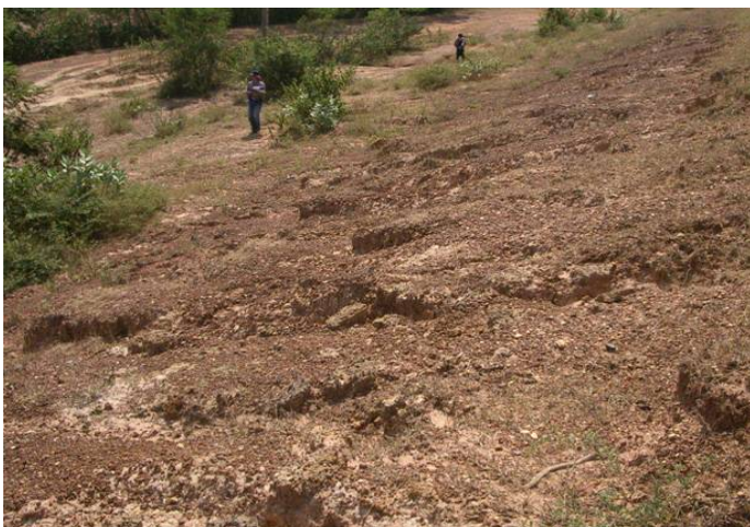
รูปที่ 23 การกัดเซาะตัวเขื่อน
