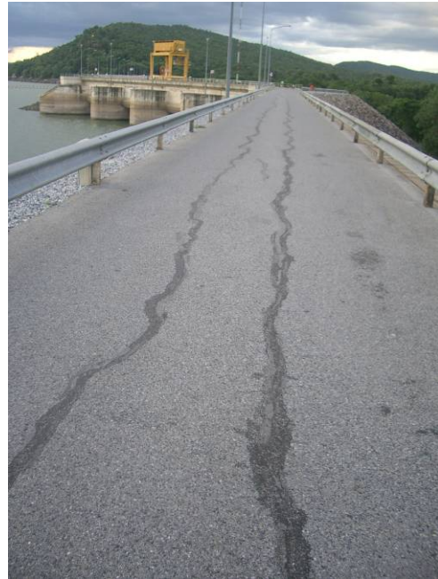
รูปที่ 13 การแตกตามยาวของเขื่อนอุบลรัตน์เนื่องจากการเสริมสันเขื่อน
