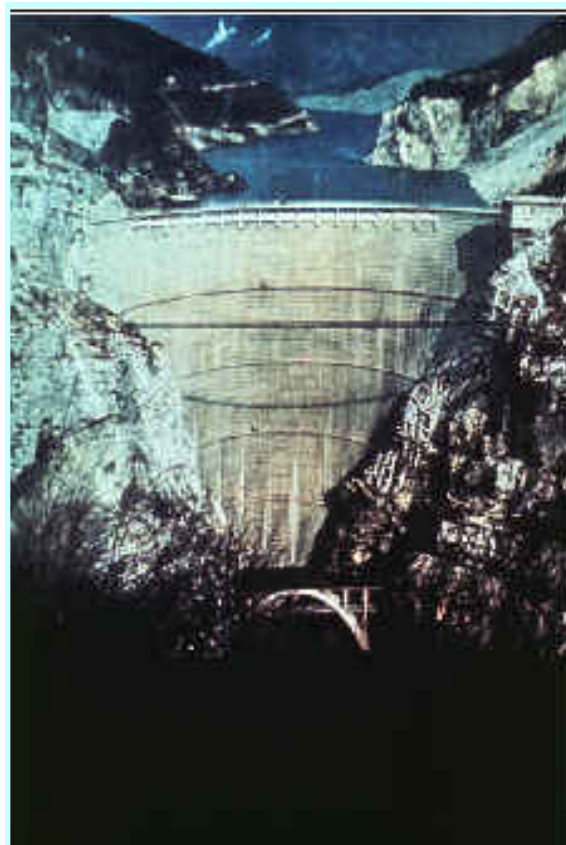
รูปที่ 21 สภาพทางธรณีที่เอื้ออำนวยในการเกิดดินถล่มลงในอ่างเก็บน้ำเขื่อน Vaiont
