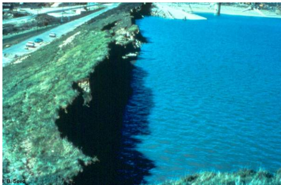
รูปที่ 28 ความเสียหายของเขื่อน Lower San Fernando ปี พ.ศ. 2514 (USGS, 1995)
