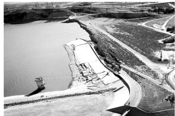
รูปที่ 28 ความเสียหายของเขื่อน Lower San Fernando ปี พ.ศ. 2514 (USGS, 1995)
