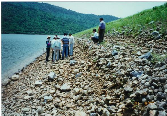
รูปที่ 22 การพิบัติจากการกัดเซาะ
