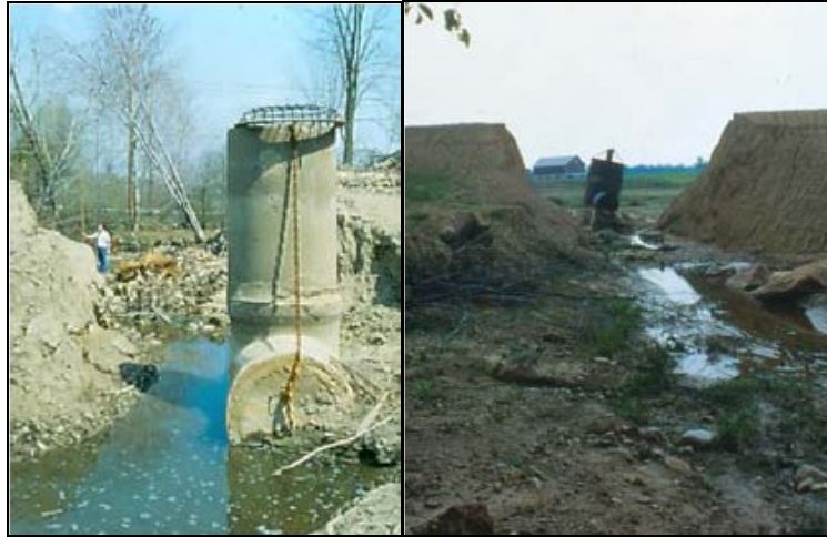
รูปที่ 2 การกัดเซาะภายในบริเวณรอบท่อส่งน้ำจนเกิดการพิบัติของเขื่อน
