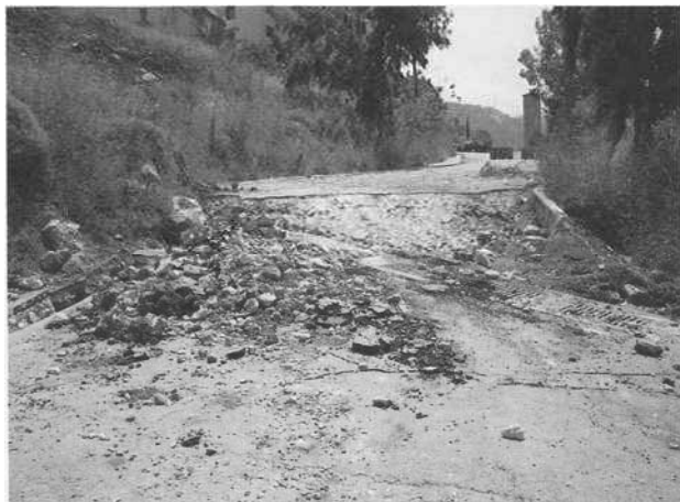
Figure 3. Route Faouar Antélias-Raboueh coupée par le glissement.
