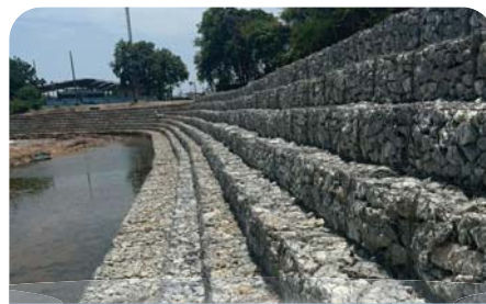
Geogrid IIa: Geotextile สำหรับงานป้องกันการกัดเซาะตลิ่ง กรมโยธาธิการและผังเมือง
