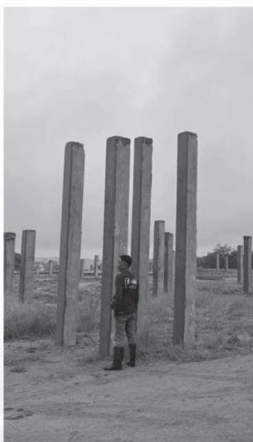
หากไม่เจาะสำรวจชั้นดินก่อนตอกเสาเข็มอาจทำให้เสาเข็มที่ตอกไม่เหมาะกับประเภทชั้นดิน
