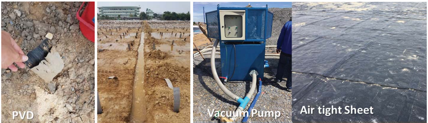
รูปที่ 2 อุปกรณ์ที่ใช้ในการปรับปรุงคุณภาพดินเหนียวอ่อนด้วยวิธี Vacuum Consolidation Method ที่มา : ศาสตรศิลป์ (2562)
