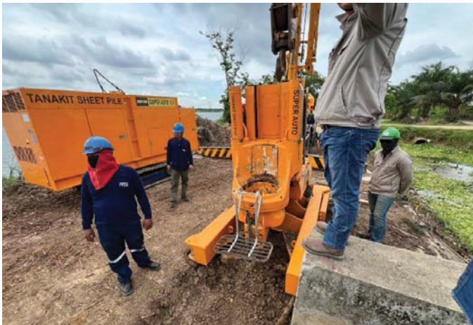
ก) การตอก Sheet pile โดย Silent piler
