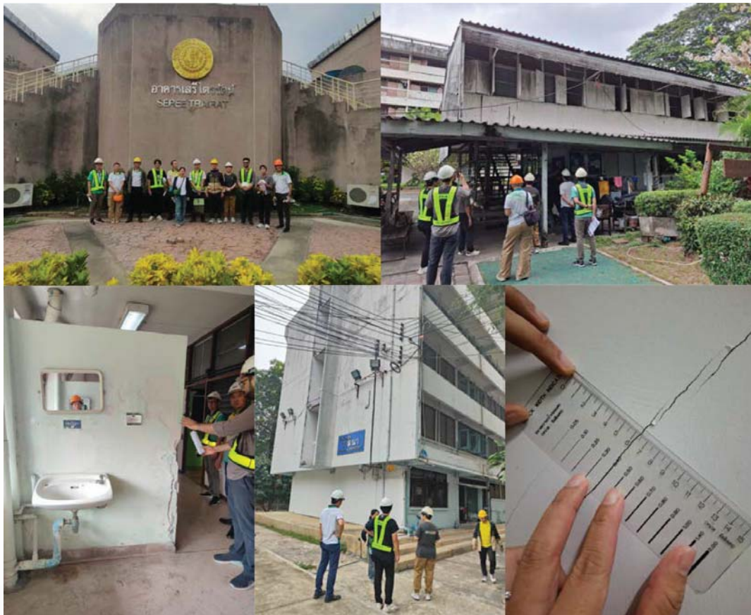
รูปที่ 4 การสำรวจตรวจสอบโครงสร้างอาคารที่อยู่ภายใต้การดูแลของหน่วยงานหอพักและกายภาพ มหาวิทยาลัยเกษตรศาสตร์ เมื่อวันที่ 31 มีนาคม พ.ศ.2568
