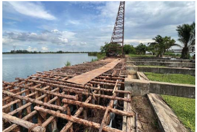
ข) การตั้งนั่งร้านเพื่อตอกเสาเข็ม
