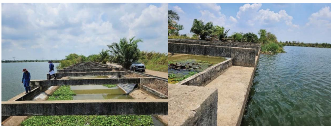
รูปที่ 2 สภาพพื้นที่ก่อนการเสริมความมั่นคง (11 พ.ค. 66)
