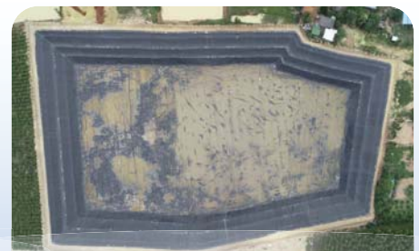
HDPE Geomembrane บ่อบำบัดน้ำเสียโรงงานอุตสาหกรรม
