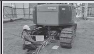
งานทดสอบ Plate Bearing Test
