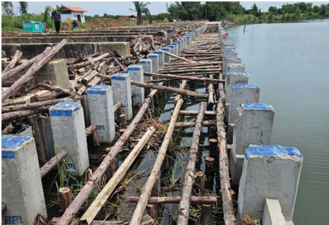
ค) การตอกเสาเข็ม
