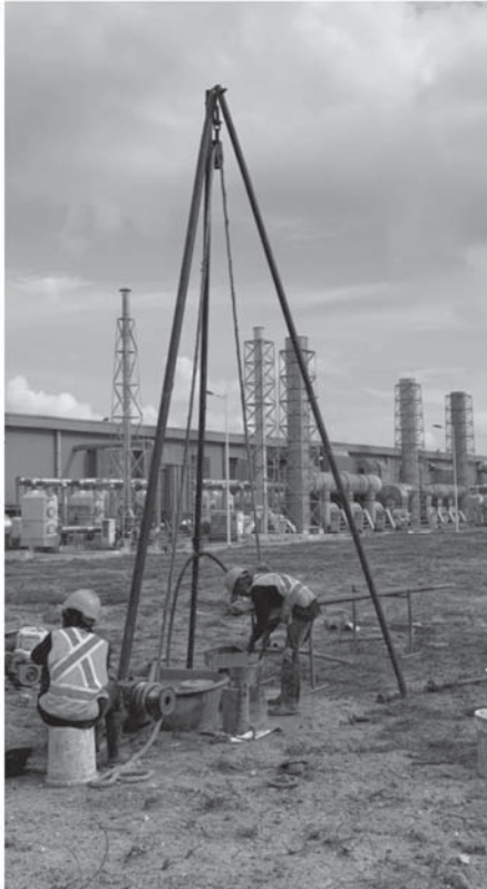
ภาพการเจาะสำรวจชั้นดินด้วยเครื่องกระทุ้ง (3 ขา)
