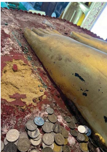
รูปที่ 3 ลักษณะความเสียหายของวัสดุ ปิดผิวบริเวณฐานพระบาท
