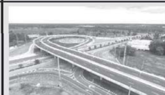
งานสะพานและถนน
