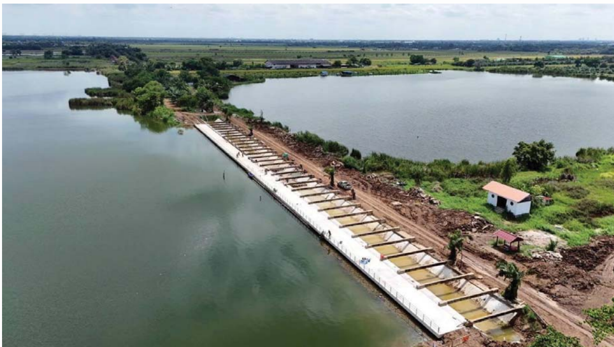
รูปที่ 36 โครงสร้างเสริมความมั่นคงบริเวณพื้นที่บ่อดินตามแนวท่อก๊าซ (23 ก.ย. 68)
