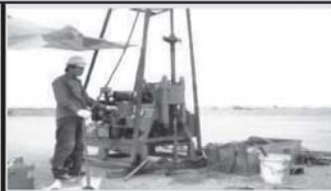
งานเจาะสำรวจดิน
