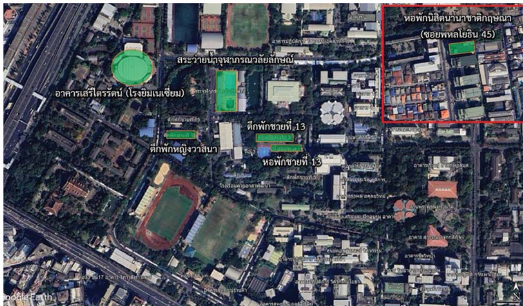
รูปที่ 3 ตำแหน่งอาคารที่ทำการสำรวจตรวจสอบโครงสร้างขั้นต้นหลังเหตุการณ์แผ่นดินไหว
