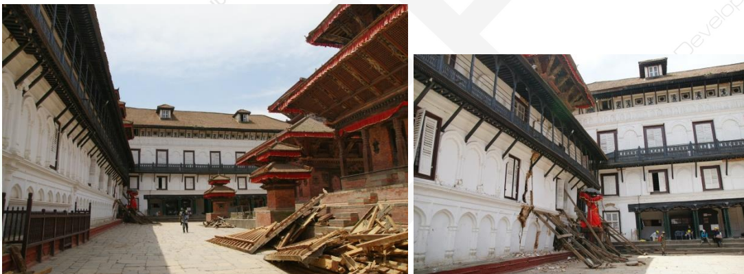
รูปที่ 11 ความเสียหายของส่วนต่อของอาคารที่วางตั้งฉากัน
