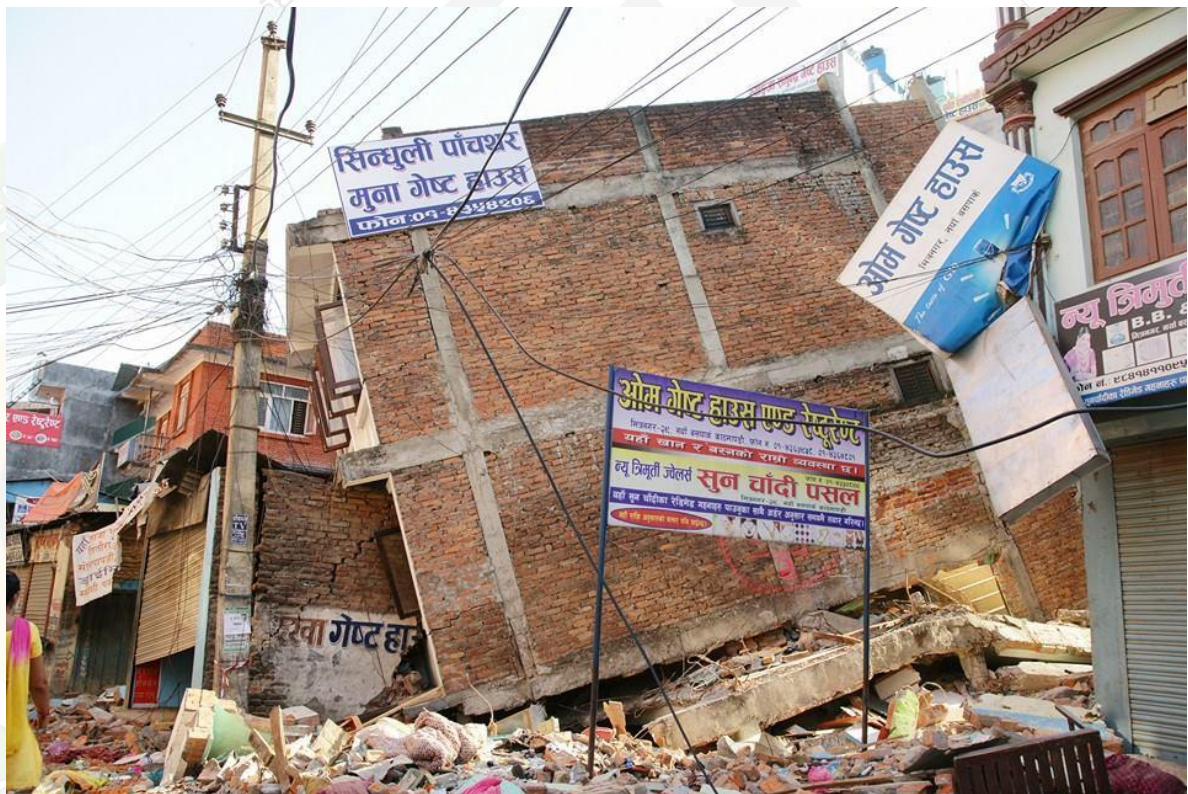
รูปที่ 6 (ต่อ) อาคารที่เสียหายเพราะ Base shear
