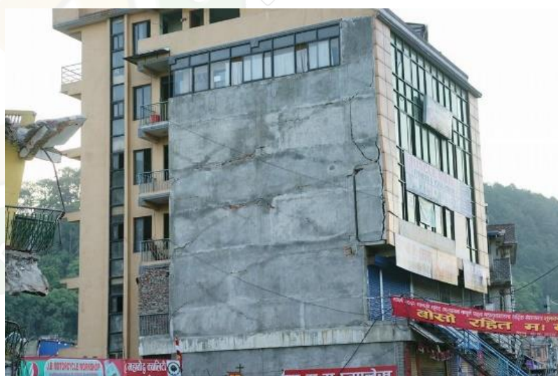
รูปที่ 8 ผนังของอาคารแตกเป็นกากบาท อย่างชัดเจน
