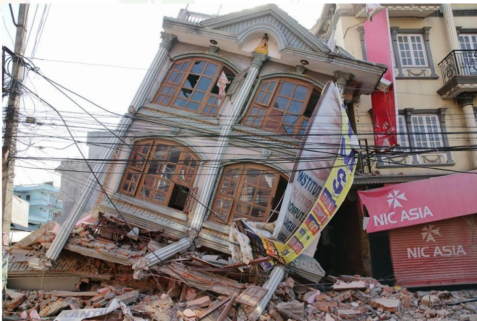
รูปที่ 6 อาคารที่เสียหายเพราะ Base shear
