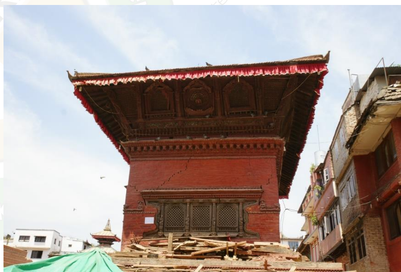
รูปที่ 10 ลักษณะอาคารที่มีส่วนบนใหญ่และชายคายื่น
