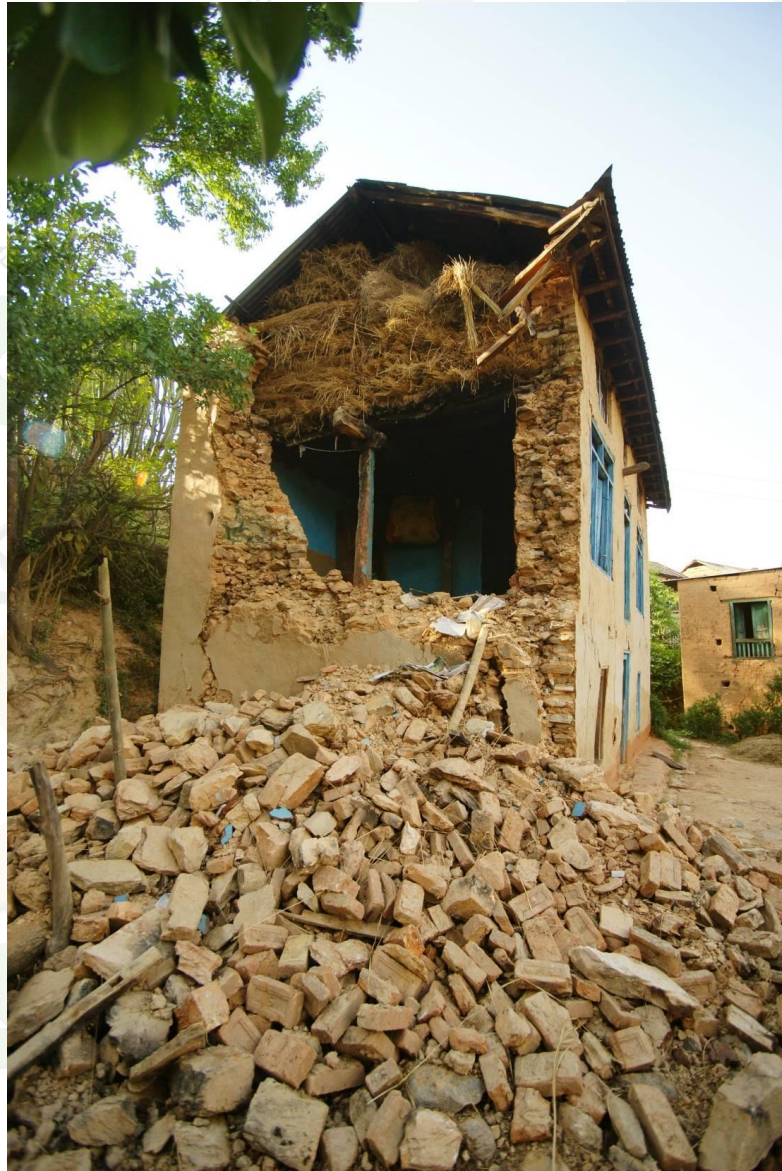
รูปที่ 16 การพังทลายของอาคารอิฐหรือหินก่อ
