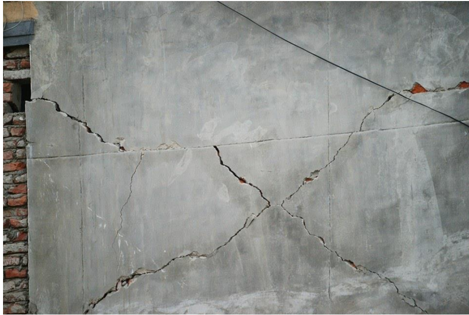
รูปที่ 8 (ต่อ) ผนังของอาคารแตกเป็นกากบาท อย่างชัดเจน
