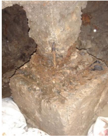
รูปที่ 8 ความไม่สมบูรณ์ของเสาตอม่อ โดยเฉพาะตรงโคนที่การเทคอนกรีตไม่สมบูรณ์
