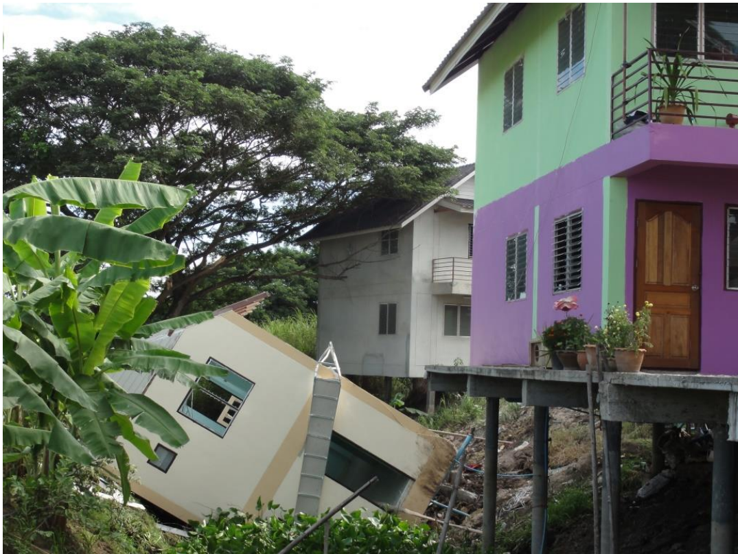
รูปที่ 12 บ้านล้มเนื่องจากเสาเข็มเยื้องศูนย์ (สุทธิศักดิ์, 2556)
