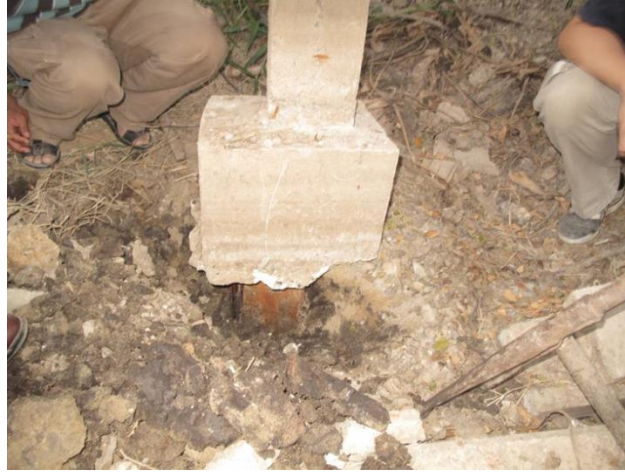
รูปที่ 11 เสาเข็มเยื้องศูนย์กลางกับเสาตอม่อ ทำให้เกิดการบิดที่ตอม่อ หรือฐานรากหลุดหัวเข็ม
