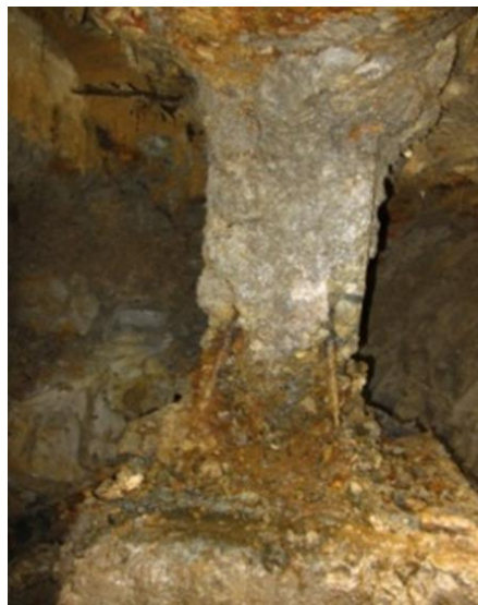
รูปที่ 9 การเสื่อมสภาพของเสาตอม่อและการเป็นสนิมของเหล็กเสริม
