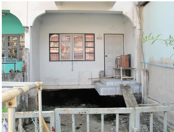
รูปที่ 17 การทรุดตัวของพื้นที่รอบบ้านที่สร้างในพื้นที่บ่อเก่า (สุทธิศักดิ์, 2556)
