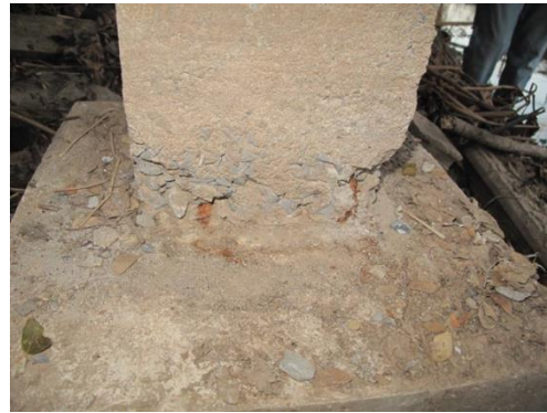
รูปที่ 8 ความไม่สมบูรณ์ของเสาตอม่อ โดยเฉพาะตรงโคนที่การเทคอนกรีตไม่สมบูรณ์
