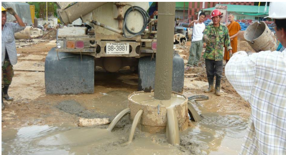
รูปที่ 31 การก่อสร้างเสาเข็มเจาะในหิน
