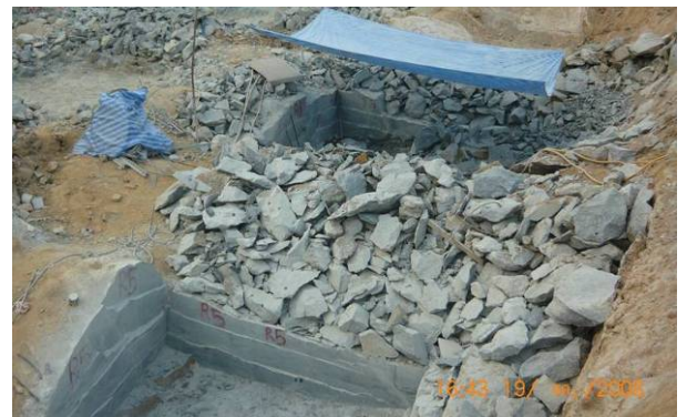
รูปที่ 45 การตัดหินเพื่อทำฐานรากแผ่
