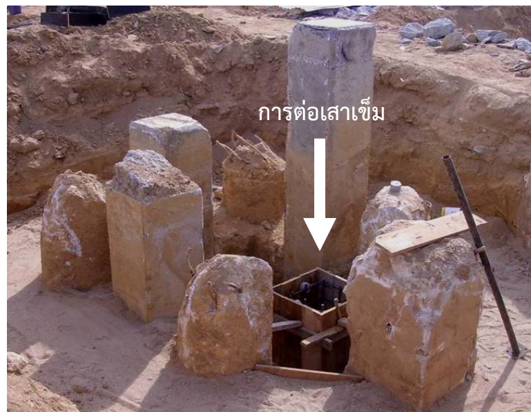
รูปที่ 24 การทำแบบหล่อเพื่อต่อเสาเข็มที่จม
