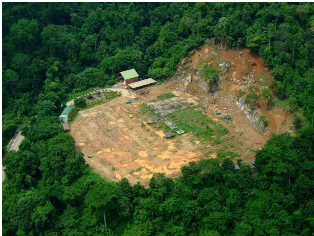
รูปที่ 3 พื้นที่ดำเนินงานก่อสร้าง
