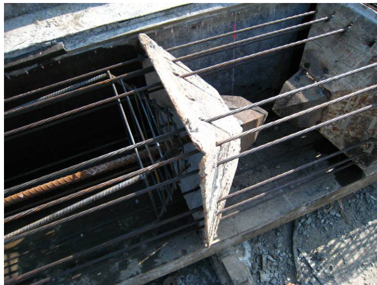
รูปที่ 7 Steel Shoe เพื่อป้องกันปลายเสาเข็มและตอกกระแทกหินลอย
