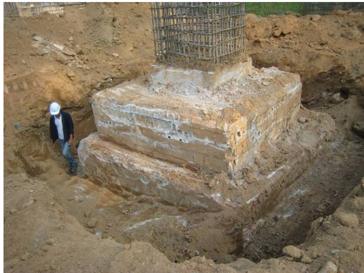
(ข). คอนกรีตรองฐานรากมีความหนาเกินไป, ไม่สม่ำเสมอ รวมถึงไม่มีการเสริมเหล็ก
