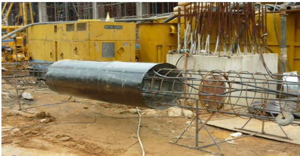
รูปที่ 30 แผ่นสังกะสีเพื่อลดแรงเสียดระหว่างเสาเข็มเจาะกับฐานรองคอนกรีตเดิม
