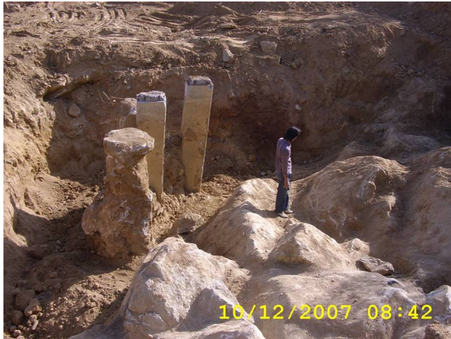
รูปที่ 21 ลักษณะความไม่เรียบของหน้าหินที่มีการเอียงตัวตามชุดรอยแตกของหินจากรูปจะเห็นเสาเข็มตอกใหม่และเสาเข็มเจาะระบบแห้งเดิม
