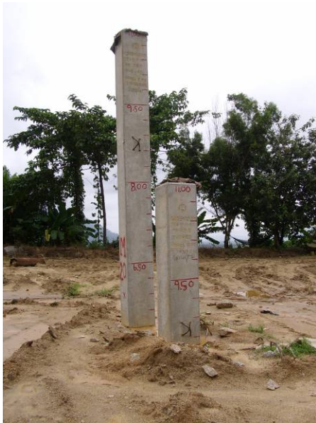
รูปที่ 23 ปลายเสาเข็มต่างระดับกันแม้จะอยู่ห่างกันไม่มาก
