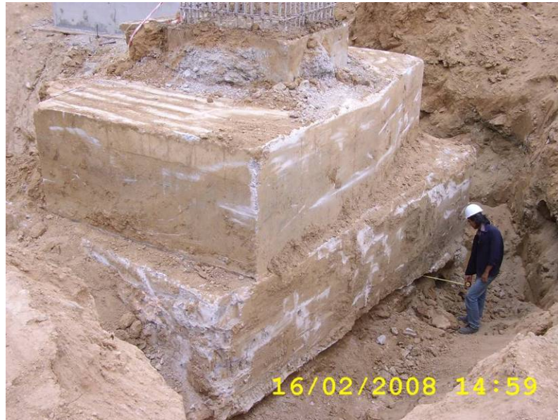
รูปที่ 44 ฐานรากบางฐานวางอยู่บนหินฟืดส่วนหนึ่งและวางบนดินถมส่วนหนึ่งอาจทำให้เกิดการบิดตัวของฐานรากจากการทรุดตัวไม่เท่ากัน
