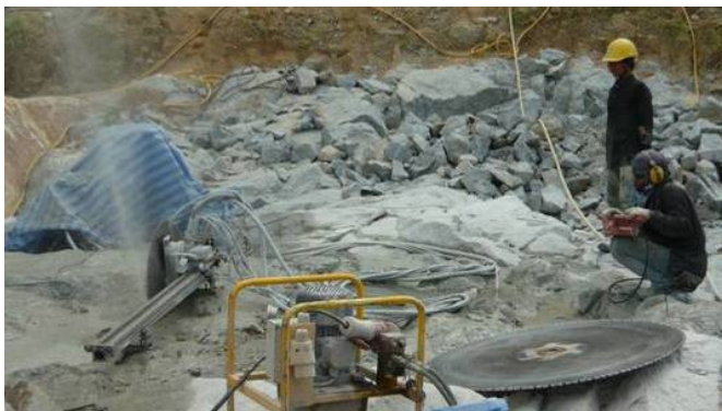
รูปที่ 45 การตัดหินเพื่อทำฐานรากแผ่
