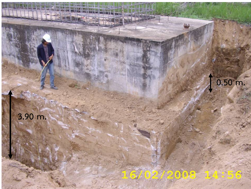
รูปที่ 26 ฐานคอนกรีตปรับระดับที่ไม่เสริมเหล็กและมีความหนาต่างกัน
