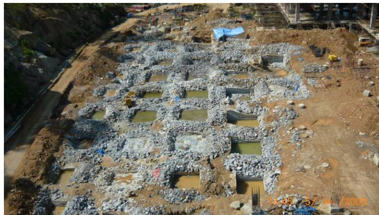
รูปที่ 44 ฐานรากบางฐานวางอยู่บนหินฟืดส่วนหนึ่งและวางบนดินถมส่วนหนึ่งอาจทำให้เกิดการบิดตัวของฐานรากจากการทรุดตัวไม่เท่ากัน
