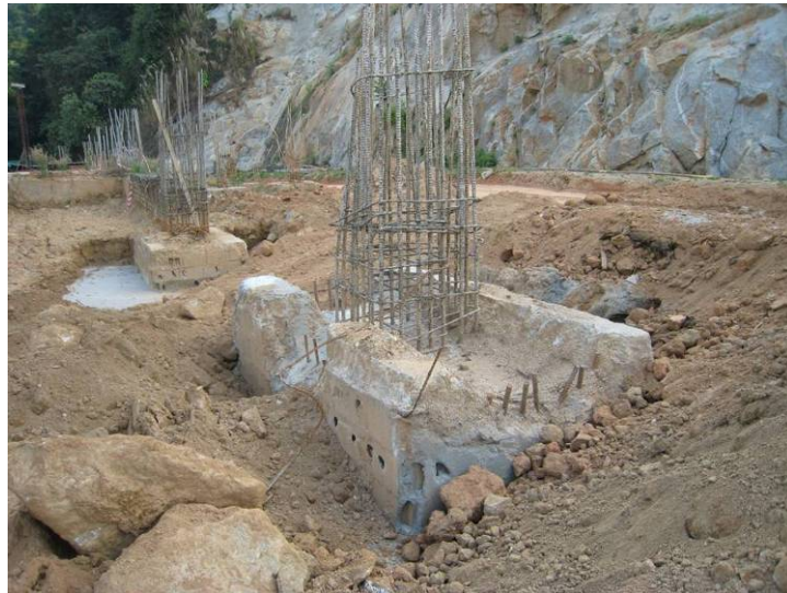
(ก). ฐานรากเก่าพบการเซาะร่องเพื่อวางคานทำให้ Effective Depth ของฐานรากเปลี่ยนไป
