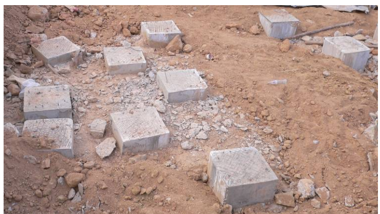
รูปที่ 22 การเอียงและหนีศูนย์ของเสาเข็ม
