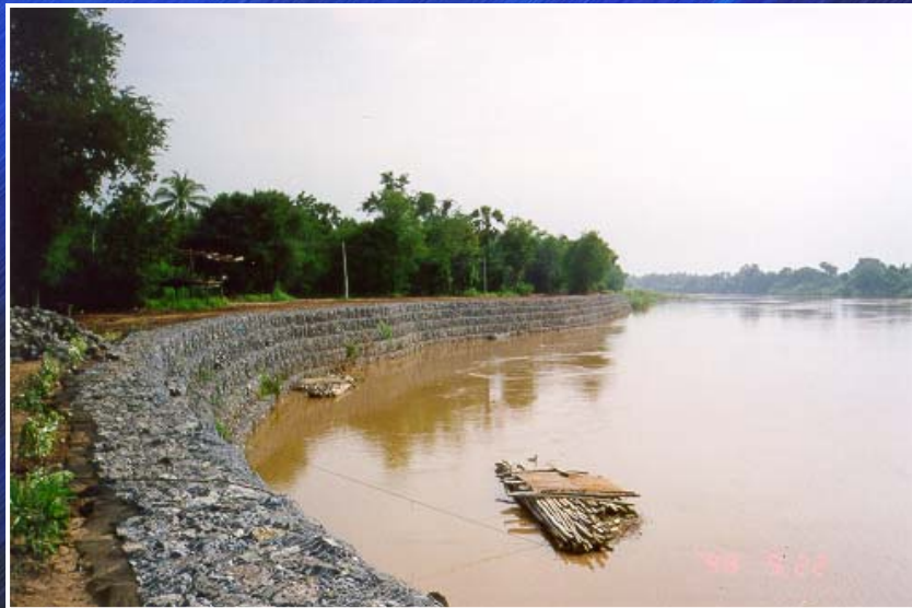
สภาพโครงสร้างเขื่อนป้องกันตลิ่งเมื่อก่อสร้างเสร็จ
