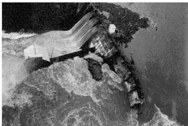
ทางระบายน้ำถูกกีดขวางและน้ำล้นสันเขื่อน
